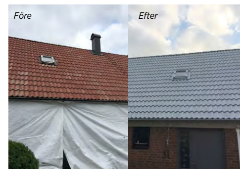
Privatvilla, Rydebäck. Ommålning av takpannor. Bild före och efter. Färg: Tikkurila Isonit.
