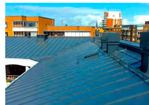
BRF Ripan, Malmö. Ca 3000 kvm takmålning, utfört av Wallstens måleri. Färg: Tikkurila Panssari Akva.
