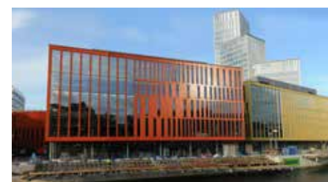
Malmö Live Golvfärg till parkeringsgarage. Färg: Tikkurila Temafloor 150 Tvåkomponent lösningsmedelsfri epoxifärg.
