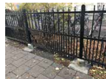
Petriskolan, Malmö Målning av 900 löpmeter staket i metall. Utfört av Tobias Nilsson, Europaint. Färg: Tikkurila Temadur 20
