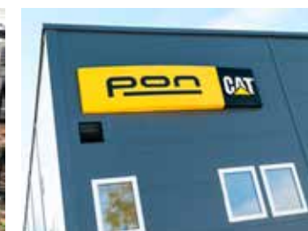
Pon Equipment Caterpillarverkstad i Eslöv, 4000 kvm utfört av Nymålat under september 2017. Färg: Tikkurila Panssari Akva.
