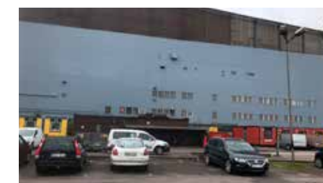
Industrifastighet Landskrona Fasadmålning med krav på hög vidhäftning, utfört av Ahnelövs Industrimålning. Färg: Noxyde.
