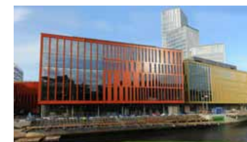
MALMÖ LIVE Golvfärg till parkeringsgarage. Färg: Tikkurila Temafloor 150. Tvåkomponent lösningsmedelsfri epoxifärg.
