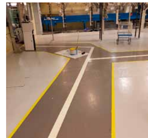
SKÅNETVÄTT, KARLSKRONA Golvfärg med fluorescerande färger för att synas i mörker. Färg: Tikkurila Fontefloor EP 100.
