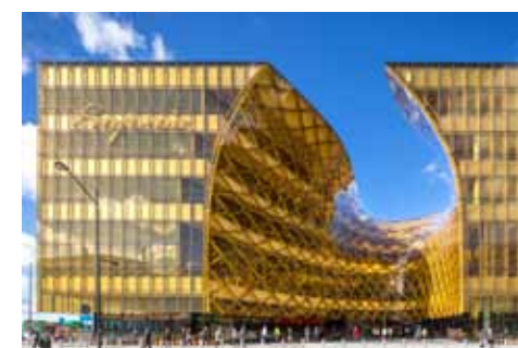
EMPORIA Målning av stålkonstruktion. Vattenburen epoxi grund.
